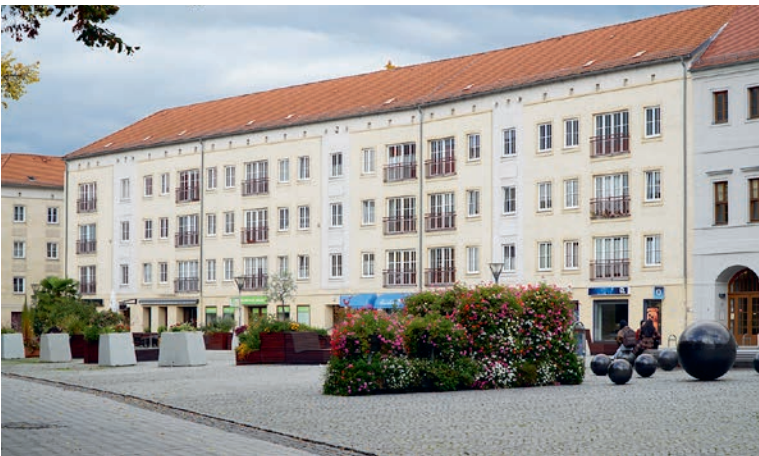
ABB. 2 Dessau-Roßlau, Teil der Ostseite der Kleinen Marktes, Fassadengliederung mit zwei Erkern (2025)
